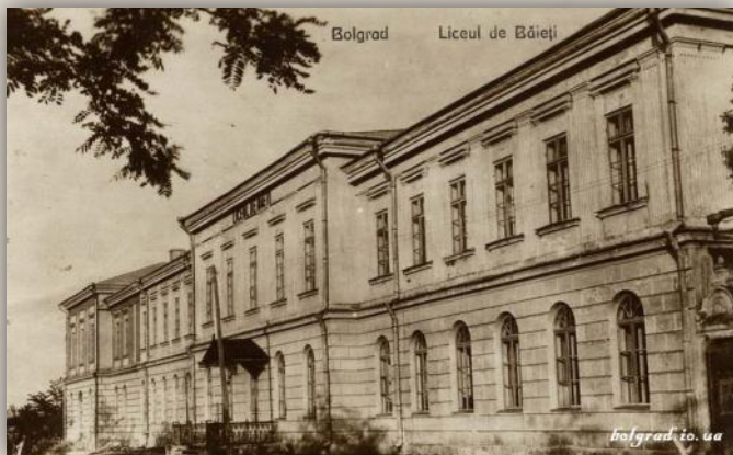
Гимназия г. Болград © https://www.etoretro.ru/pic185471.htm )
