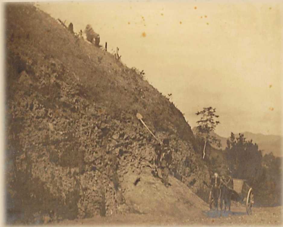
Чаква Кутаисской губ. Батумский округ. Имение удельного ведомства. Разрез латерита. Арх. ЦМП Ф.2. Оп 39. Д. 1. Л. 78
